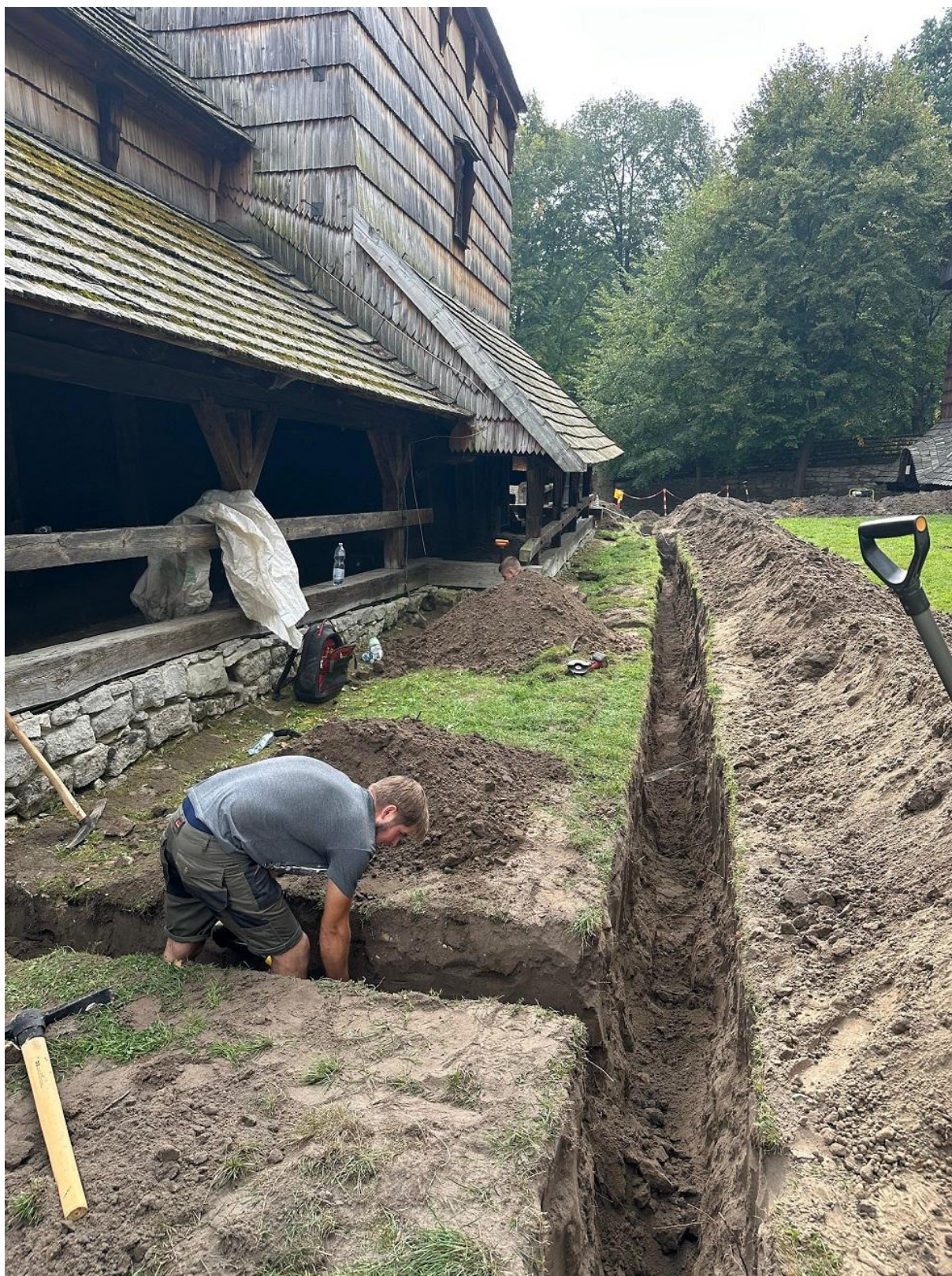
Fot. 119. Realizacja remontu instalacji piorunochronnej w cerkwi i dzwonnicy w Zespole Cerkiewnym w Radrużu, realizacja: Usługi Elektryczne Andrzej Bogusz, wrzesień 2025 r.
