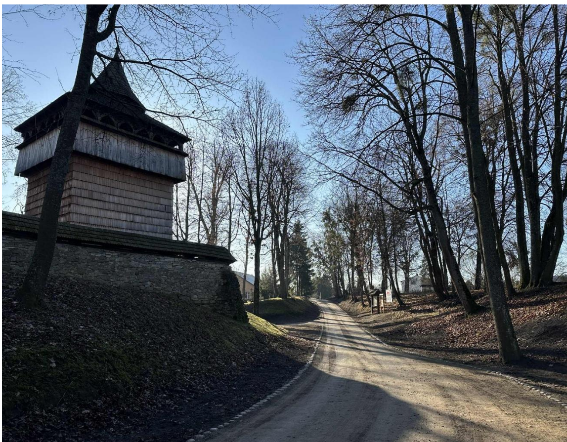
Fot. 136–137. Nowa nawierzchnia drogi gminnej przebiegającej przez Zespół Cerkiewny w Radrużu, zrealizowanej przez Gminę Horyniec-Zdrój, grudzień 2025 r.
